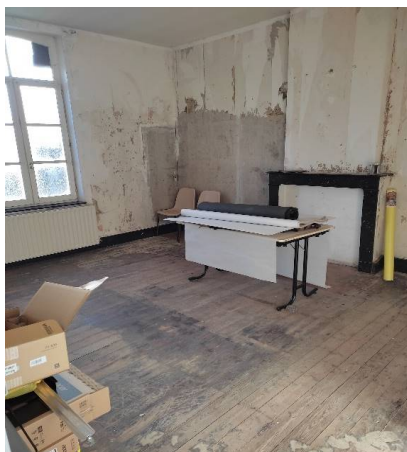
Une chambre à l'étage
