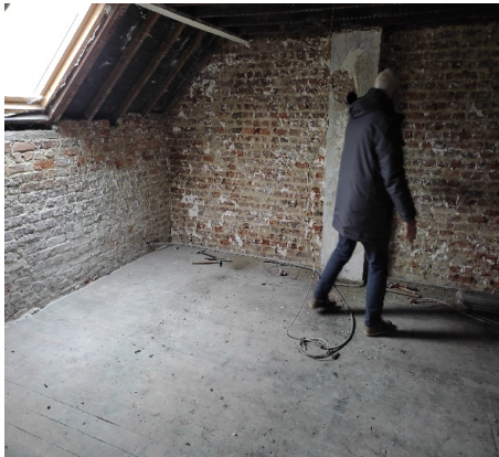
Sous les combles du 30 rue Pasteur
